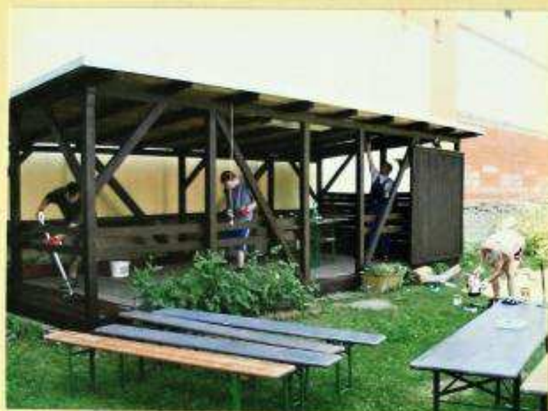
Rekonstrukce přístřešku za rybnířským domem
