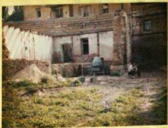
Stavba garáže pro hosp. odbor
