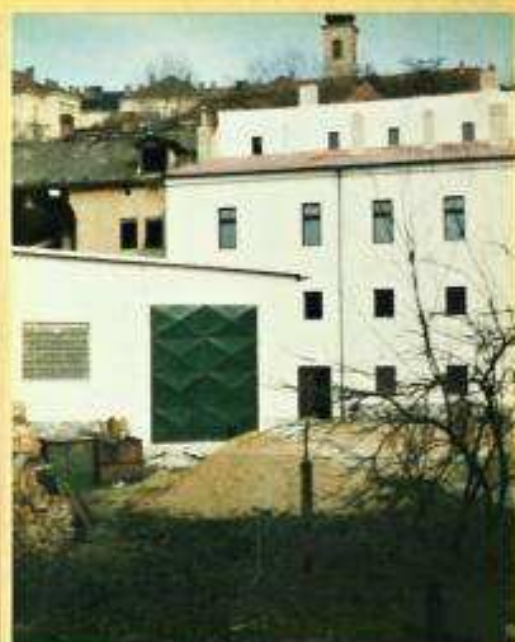
Konečná úprava dvora. Odvezeno 48 tun zeminy.
