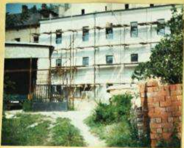
Dokončovaci úpravy fasád 1.6.92
