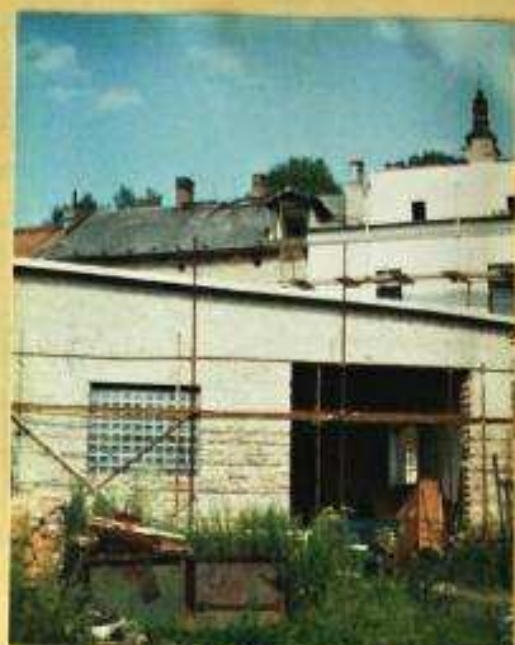
Nová stavba skladu a garáže
