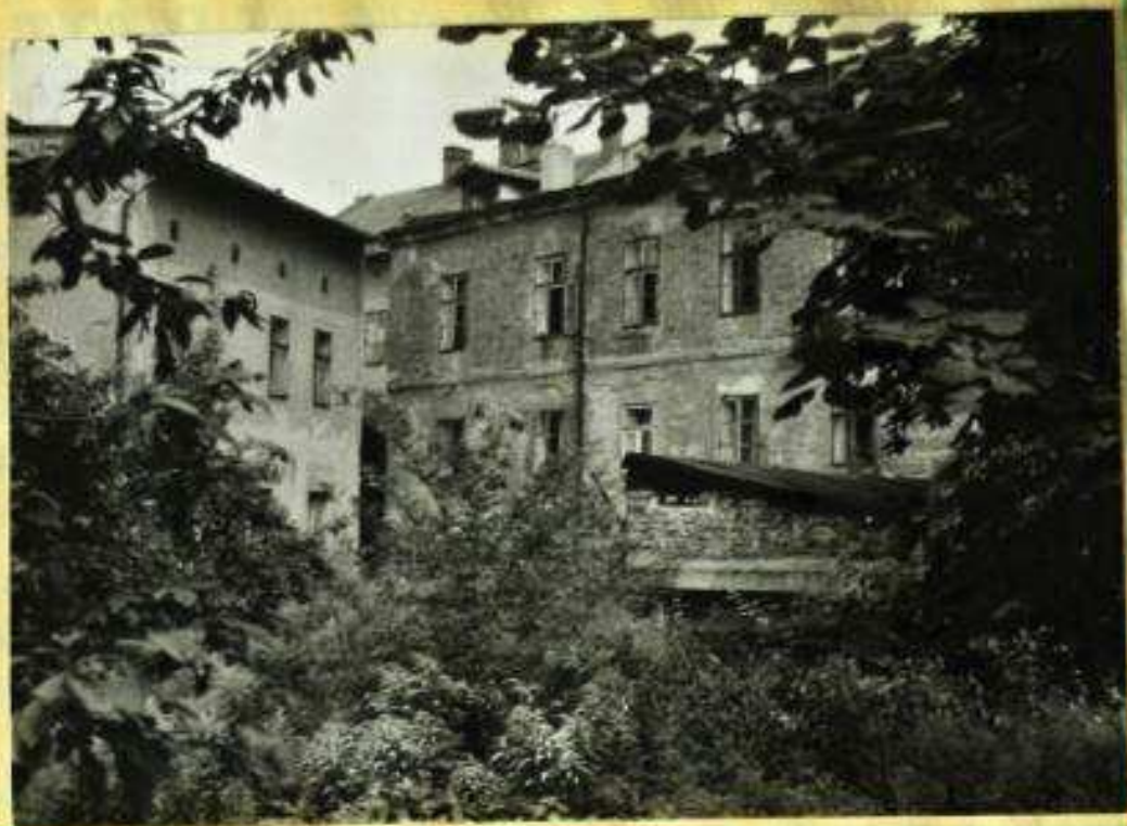
Dům v Marxově ulici
